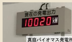
真庭バイオマス発電所
