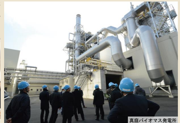
真庭バイオマス発電所
